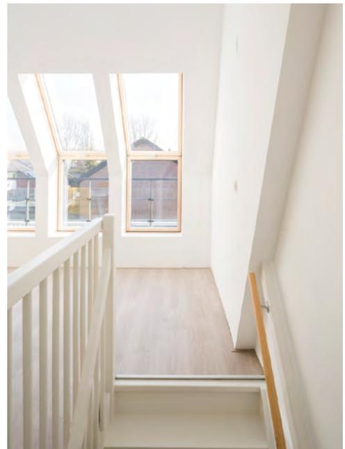
空间的延伸还表现在建筑外立面——最引人注意的是阁楼上的三角墙。建筑师将三角墙设计成了阳光放大器，在现有非对称屋顶上安装了斜面加立面组合天窗、太阳能板和彩钢瓦。这种屋顶延伸方法使得阳光可从两侧射入到阁楼中。
